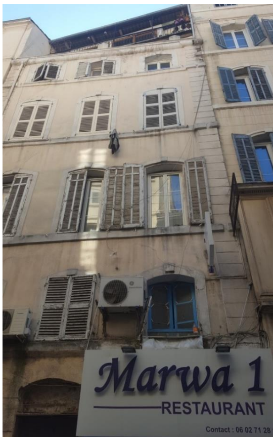
Copropriété située 6, rue d'Aubagne – 13001
